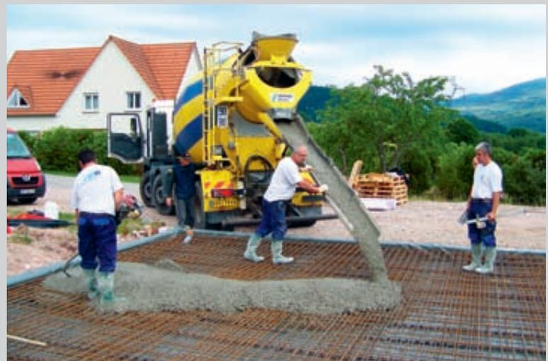
▲ Avant le coulage du béton pour la dalle porteuse, l'isolation périphérique a été réalisée avec le système d'isolation et de coffrage Jackodur Atlas.
