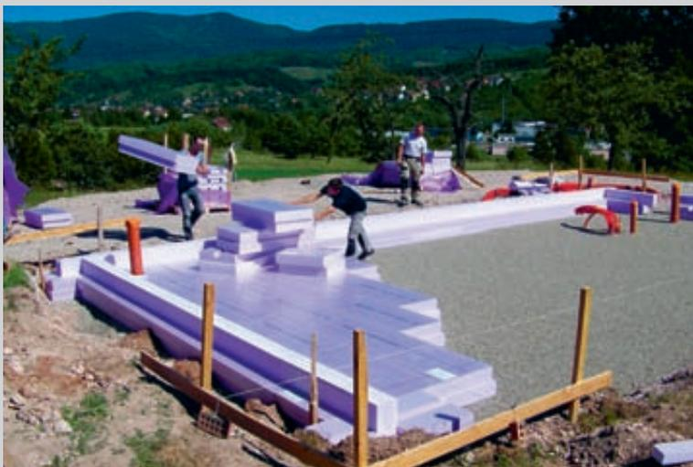
▲ Après la préparation du sol, le système d'isolation est posé dans la zone périphérique sous les dalles de répartition de charge des fondations (radier).
